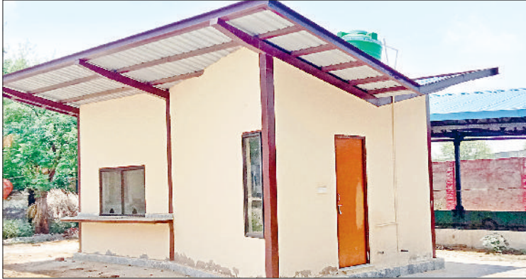
नारनौल। पॉलीटेक्निक अंडरपास के नजदीक बनाया गया सीएफसी भवन। फोटो: हरिभूमि
